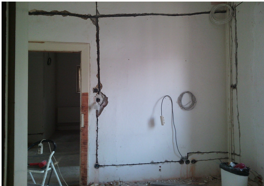
Nová elektroinštalácia v kancelárii a brúsenie zárubní
